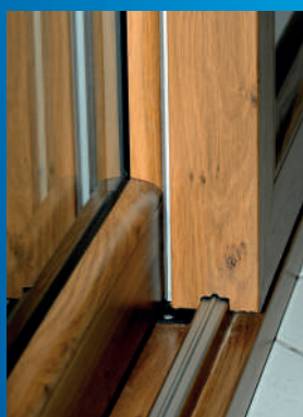
Rail de roulement de l'ouvrant.
