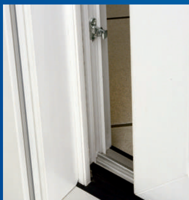
Seuil bas ALU pour passage plus aisé. Seuil encastrable pour norme PMR.
